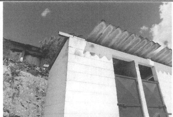
Foto 4: Mejoramiento de servicios sanitarios.
